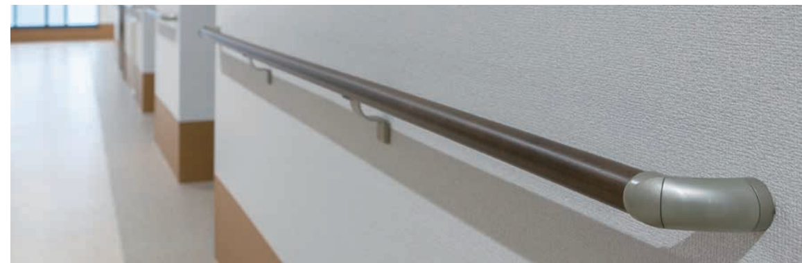
全ての階の廊下や食堂などに設置された握りやすい手摺(マルポ21)
