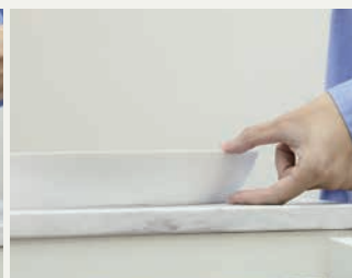
洗面ボウルは、美しく見えて使いやすい高さや固定方法を何度も検証。カウンターの取付け穴にボウルを半分ほど沈め、コーキングで接着している
