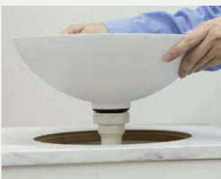
洗面ボウルは、美しく見えて使いやすい高さや固定方法を何度も検証。カウンターの取付け穴にボウルを半分ほど沈め、コーキングで接着している
